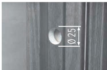
Percer le logement de la gâche de 15 mm de profondeur à l'aide d'une fraise de  $\text{Ø}25$  mm.
