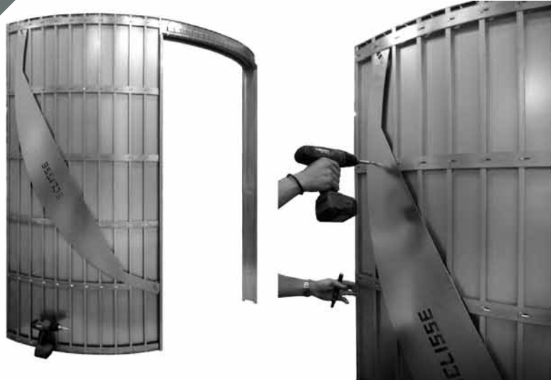
3a) Gabarit fixé au châssis.
