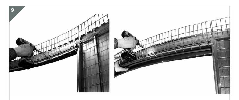
Les raccords doivent être fixés au porte-rail au travers des trous prévus à cet effet. Au moment de la fixation vérifier l'aplomb et la verticalité.
